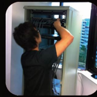
網路線鋪設 Cabling
